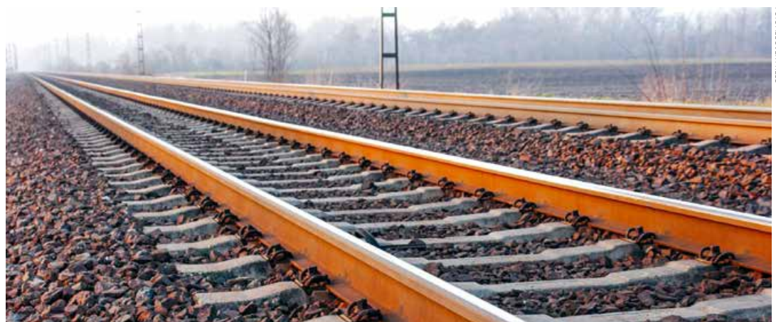
Med en ny matematisk metode er det lykkedes at bekræfte sikkerheden på en 55 km lang toglinje med otte stationer.
